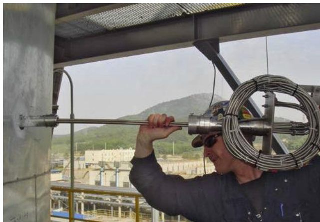
Сотрудник сервисной службы WIKA/Gayesco устанавливает многозонку Radial Tap™
